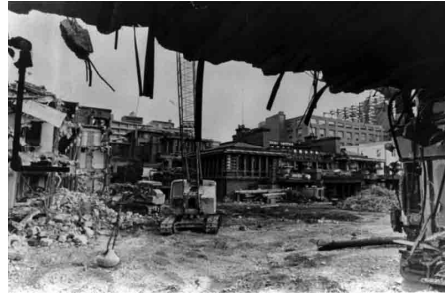
1967年、解体が進むライト館
