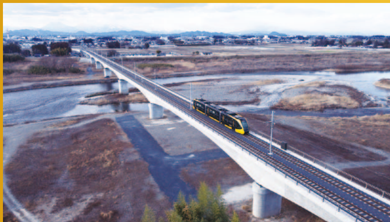
鬼怒川橋りょう(撮影 西山弘泰)
