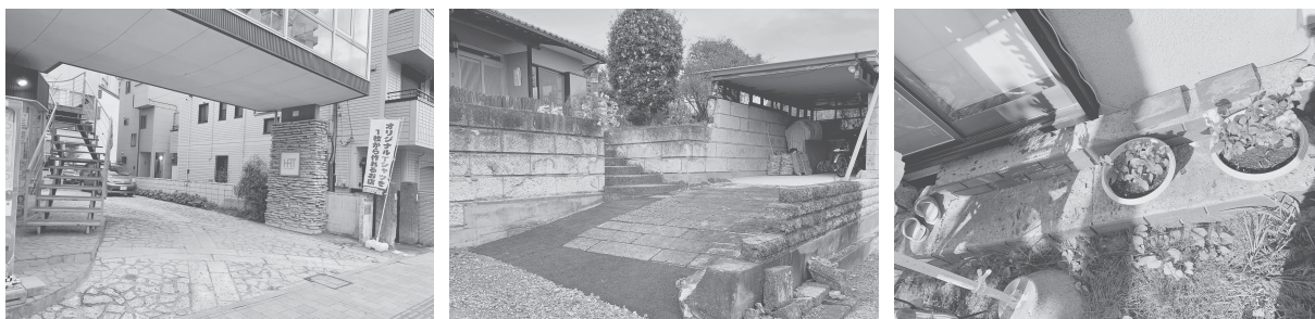
写真1～3 大谷石の古材を再利用した事例
