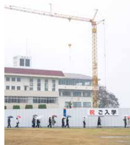
入学式 5号館建設中 (2010年)
